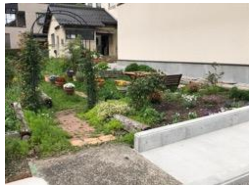
③周辺整備
