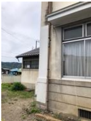
①老朽化の激しい箇所の修繕
