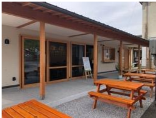
②閲覧室を併設したトイレの新設
